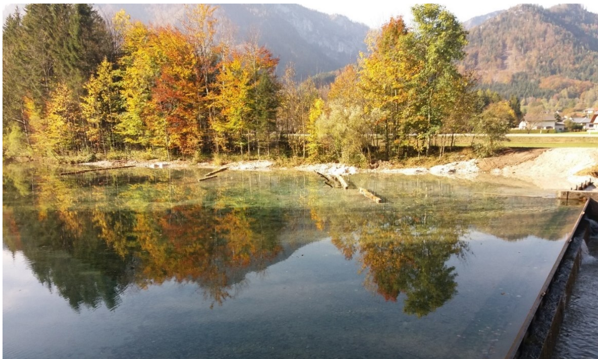
Abbildung 15: fertiggestellte Pfahlreihen vom gegenüberliegenden Ufer.
