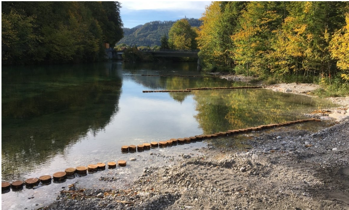
Abbildung 14: Fertiggestellte Pfahlreihen.
