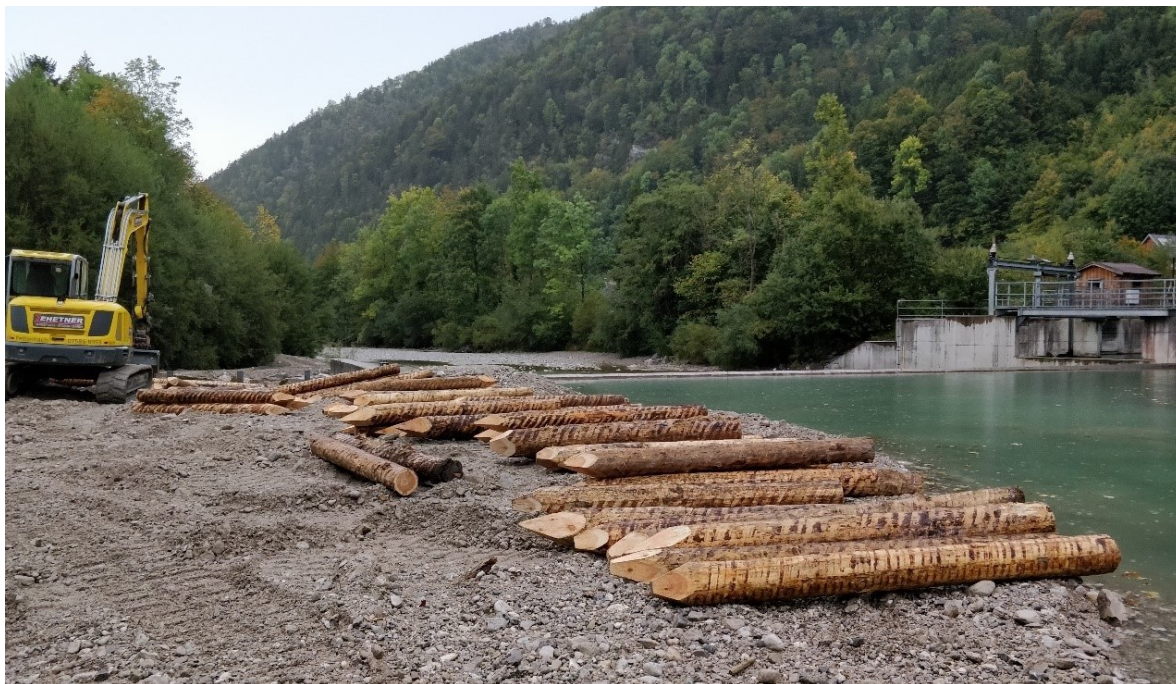
Abbildung 7: Piloten für Pfahlreihen.
