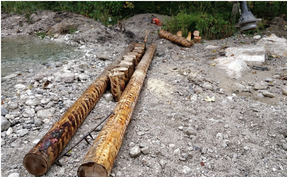
Abbildung 13: Entstehen der Pfahlreihe / Setzen der Pfähle Mann-an-Mann.
