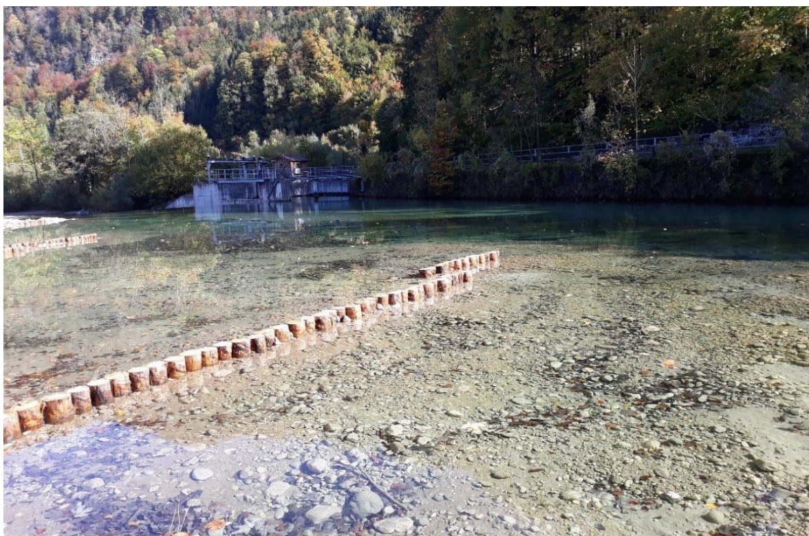
Abbildung 8: Fertiggestellte Pfahlreihe mit Wanderkorridor.
