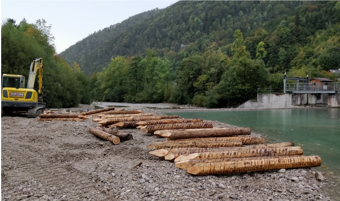
Abbildung 12: zugespitzte Lärchenpfähle
