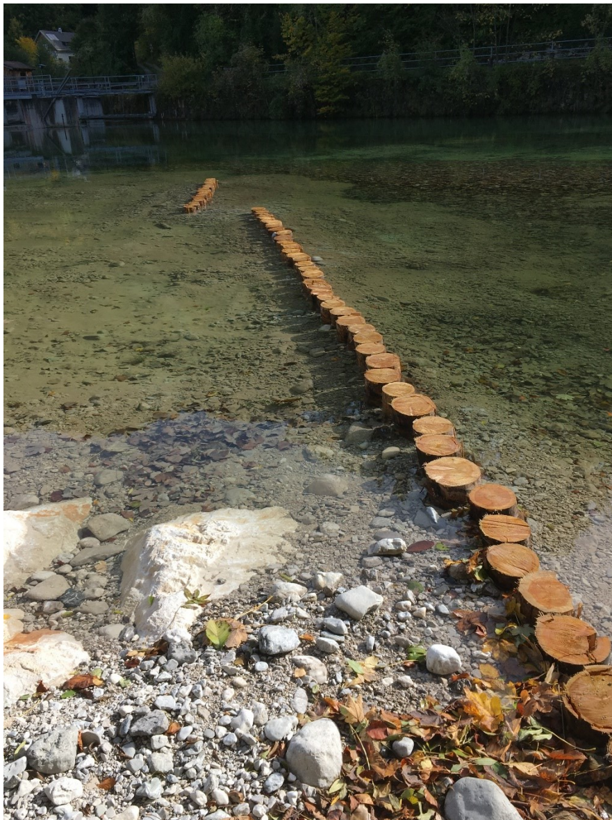
Abbildung 16: Pfahlreihe mit Wanderkorridor.
