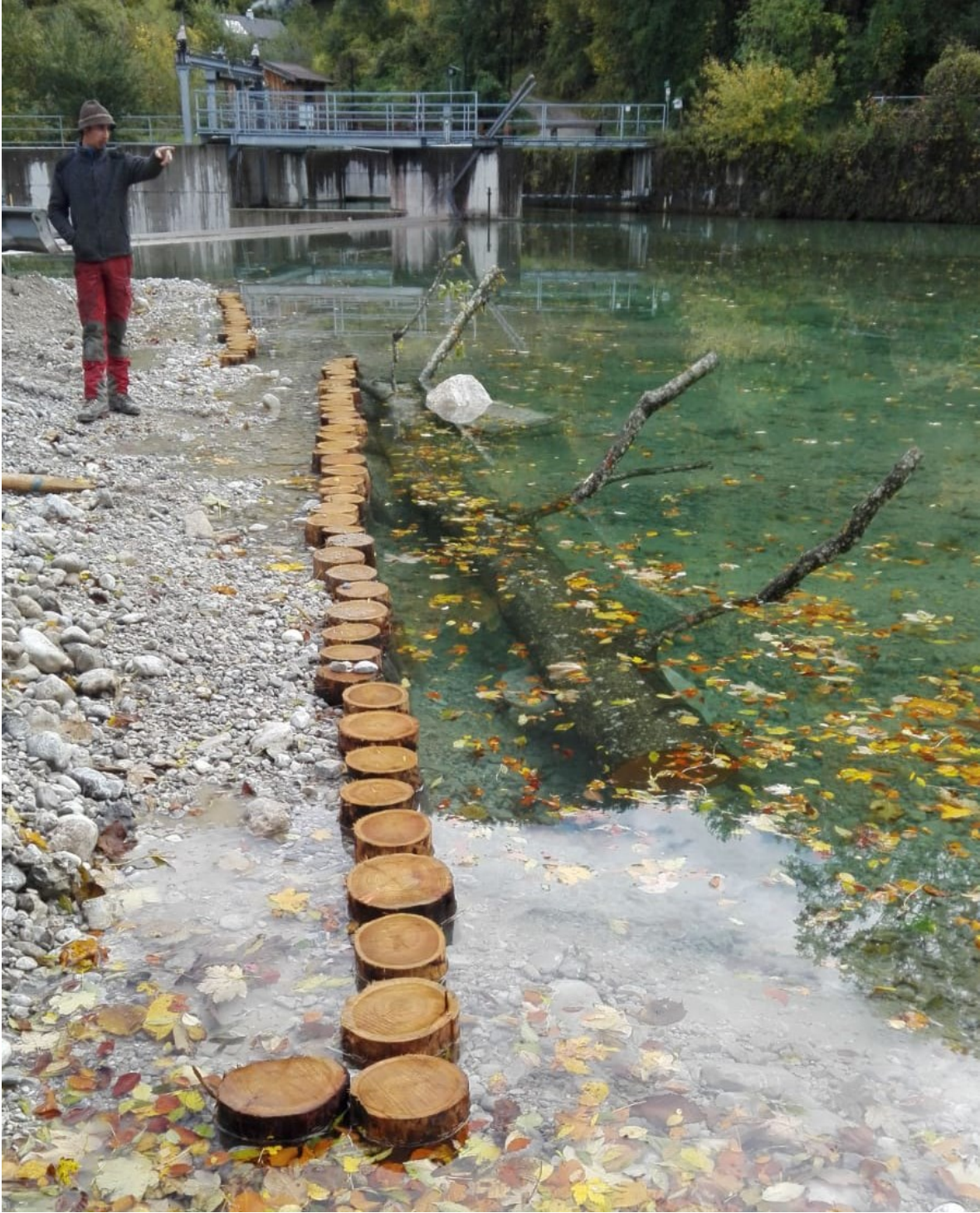
Abbildung 17: Pfahlreihe mit vertäutem Raubbaum zur Erhöhung der Habitatvielfalt im Stauraum. (Foto: Ulrike Bart)
