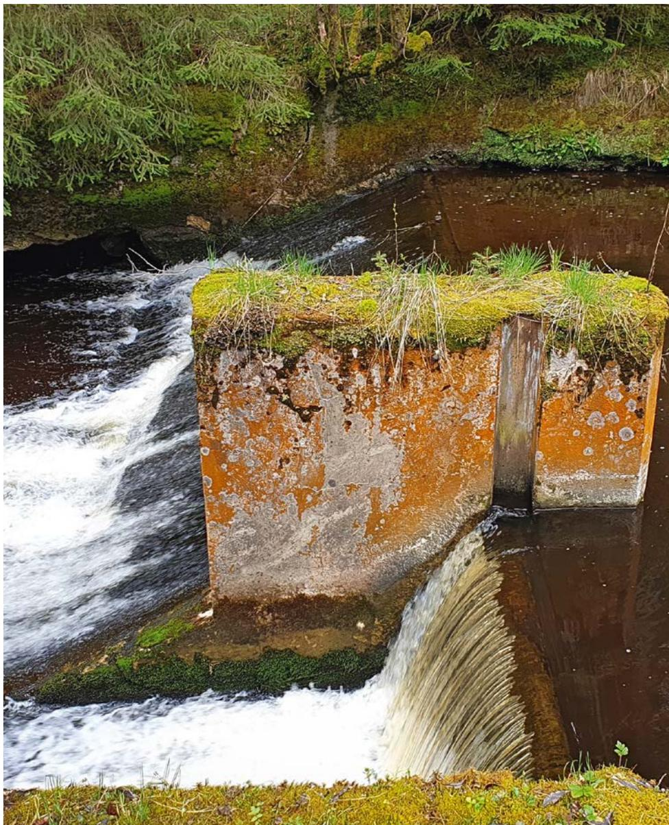
Detail des betonierten Querbauwerkes
