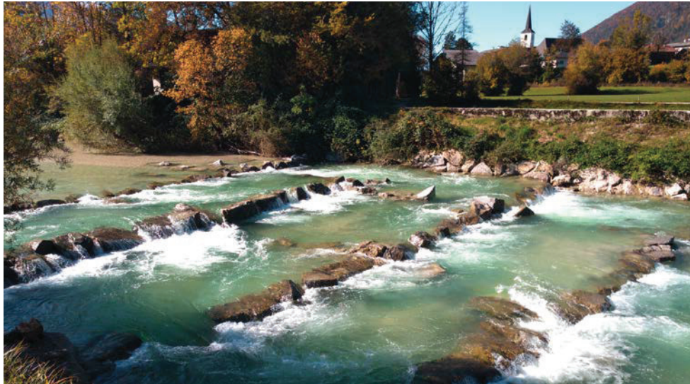
Beispiel: Aufgelöste Rampe an der Ager bei Vöcklabruck als naturnahe, für Fische und andere Organismen passierbare Alternative zum ursprünglich nicht passierbaren Absturzbauwerk
