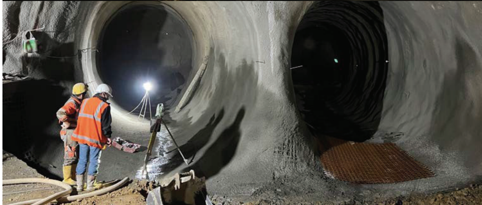
Erkundungsbohrungen in der Abzweigung
