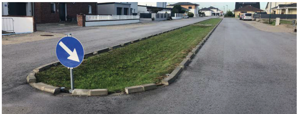
Zentrale Sickermulde in der Bachgasse, Ortschaft Engelhartstetten
