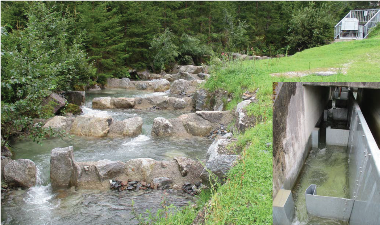
links: Fischaufstiegshilfe Beckenpass neu
