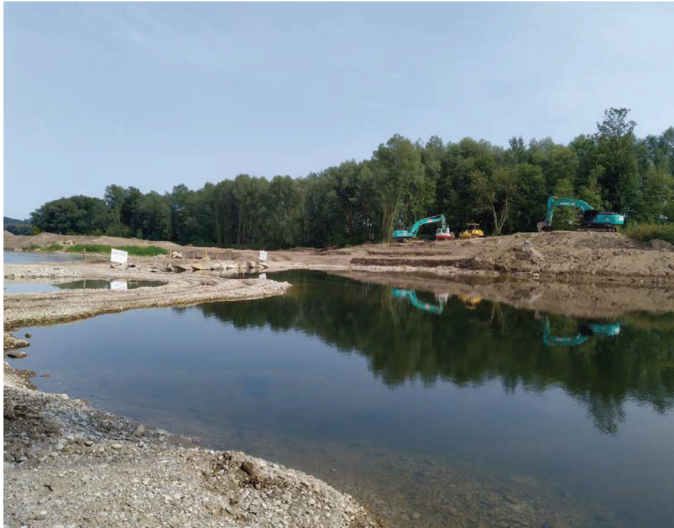
Aufnahme während der Bauphase
