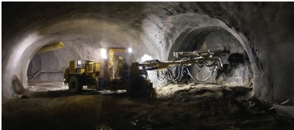
Abzweigung im Quellstollen
