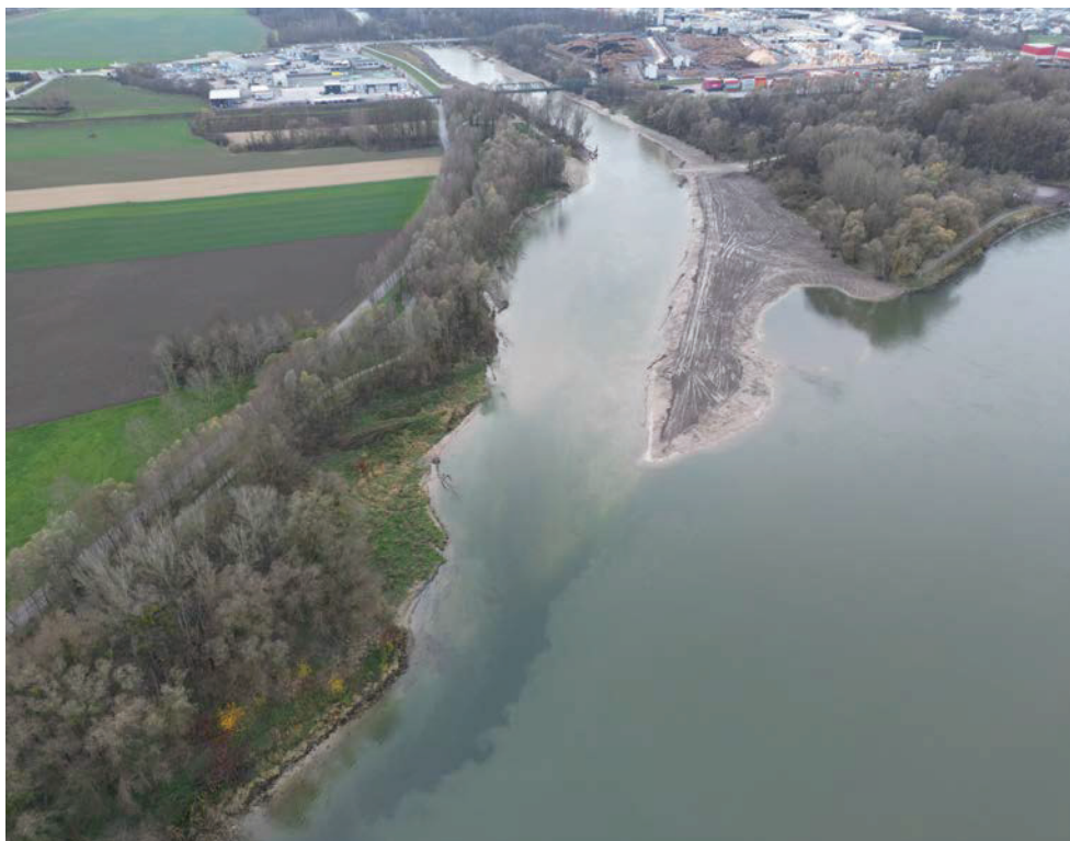
Drohnenaufnahme nach Fertigstellung
