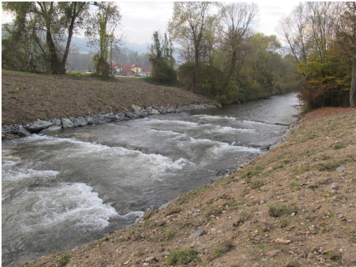
Abb. 2: Zu einer Sohlrampe umgebaute Sohlstufe Blaiken
