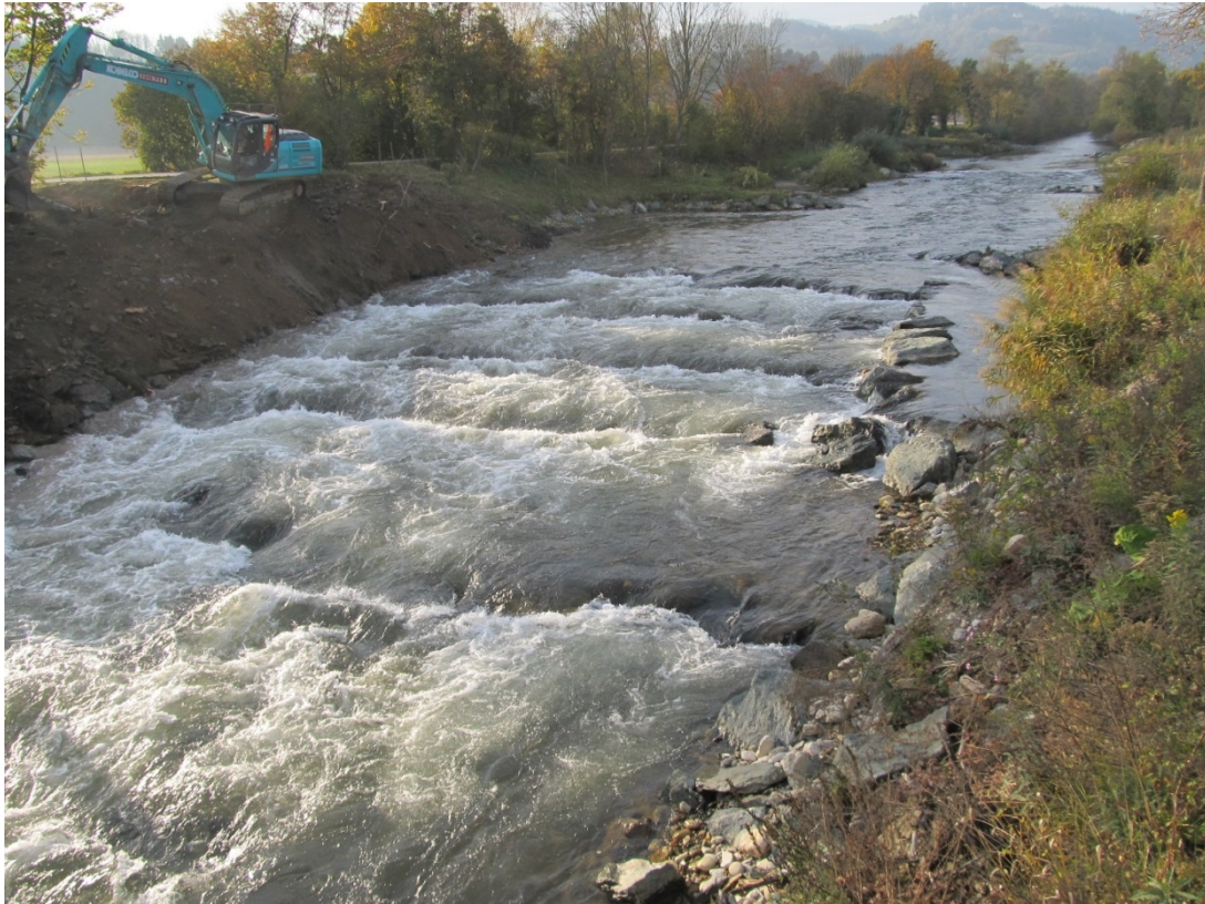
Abb. 4: Zu einer Sohlrampe umgebaute Sohlstufe bei Mettersdorf
