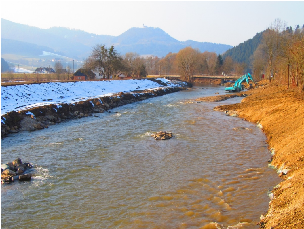
Abb. 9: Baumaßnahmen zur Restrukturierung bei Altach
