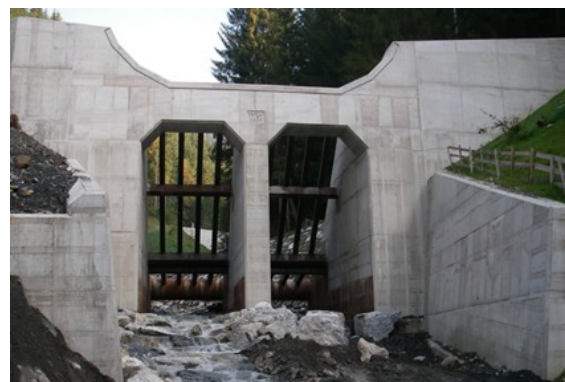
Abbildung 1 und 2: Bautyp von einer Retentionssperre und Geschiebedosiersperre
