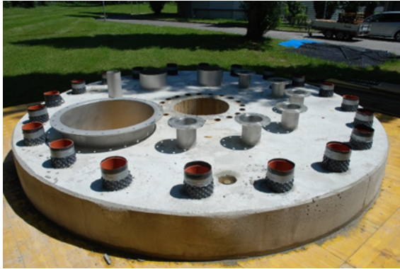
Abbildung 108 Erneuerung der Faulturmdeckel mit Antrieb für das Scaba Rührwerk.
