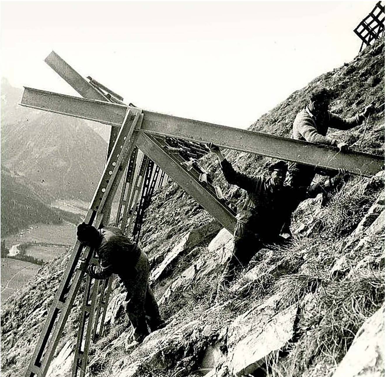
Abbildung 2: Entstehung einer Lawinverbauung am Häselgehr (Tirol) 1965
