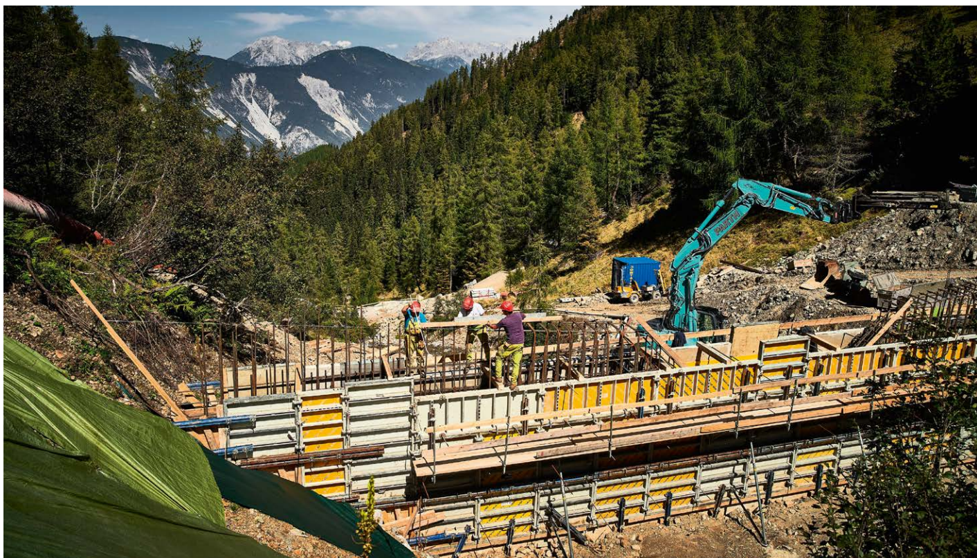
Abbildung 7: Baubetrieb der WLV
