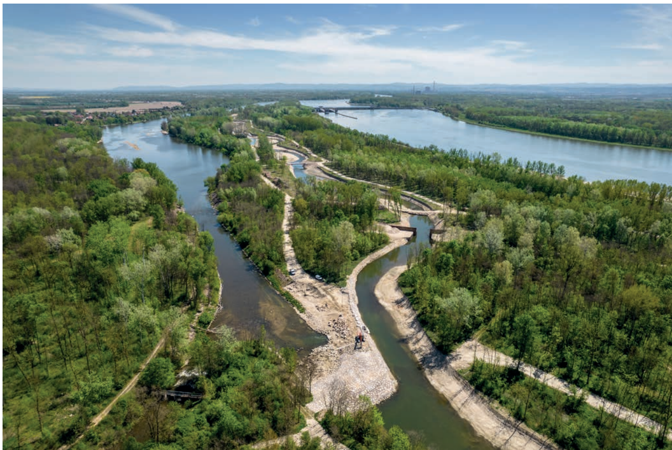
Fischwanderhilfe beim Kraftwerk Altenwörth in der Bauphase
