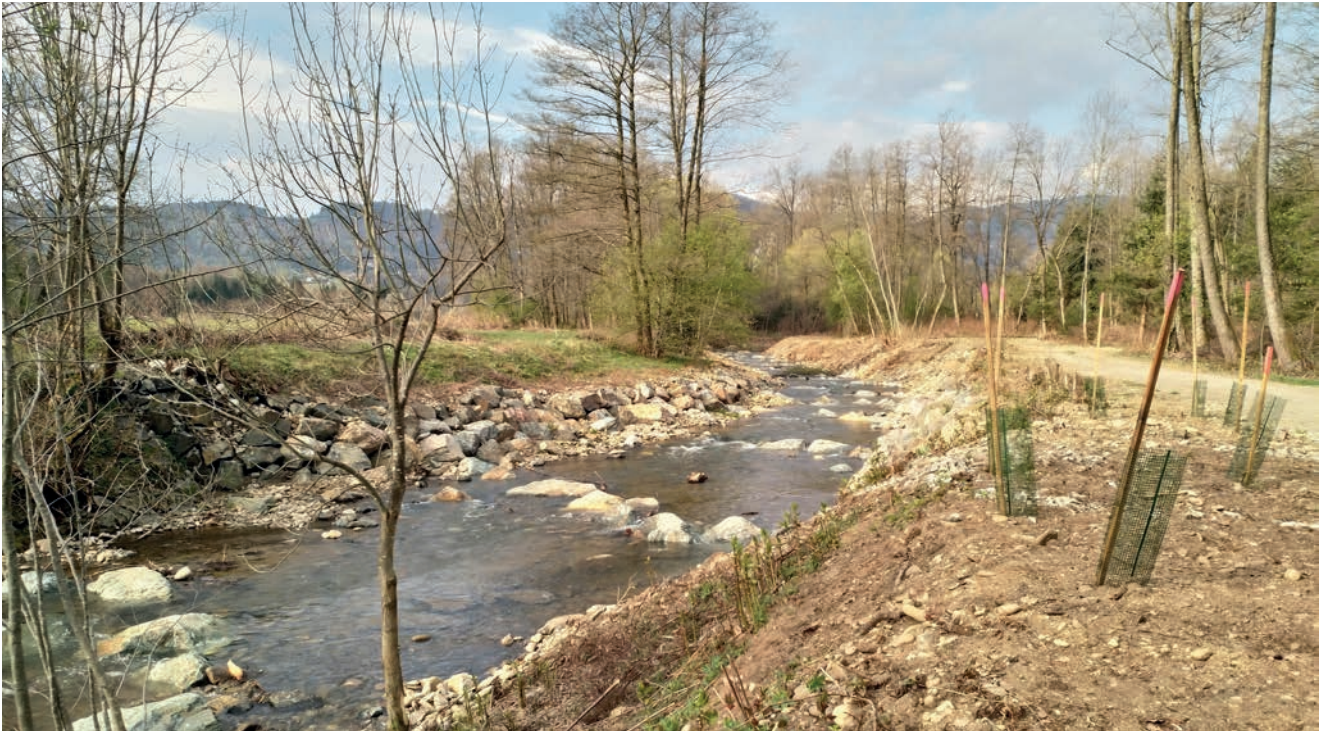
Wiederhergestellte Gefälleverhältnisse im Bereich des ehemaligen Querbauwerkes bei Kerschbaum
