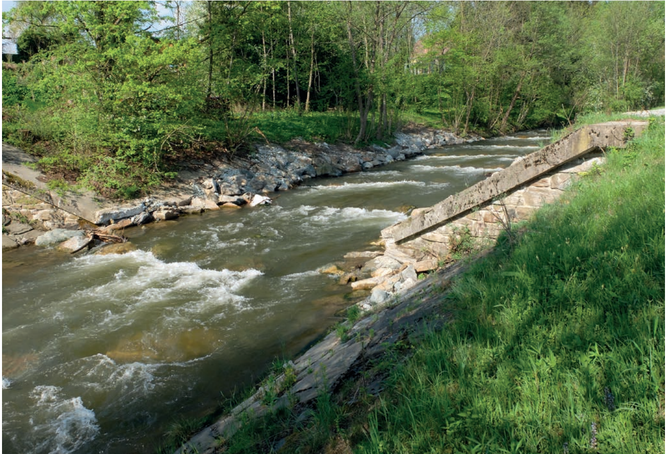
Riegelrampe im Bereich des ehemaligen Querbauwerkes bei Gasselsdorf
