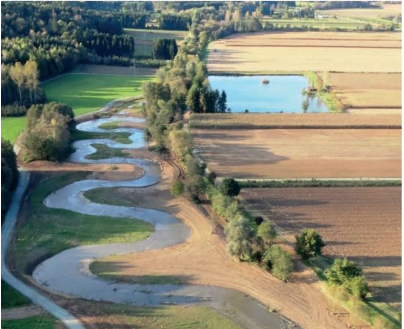
Mäanderschleifen der Pinka unmittelbar nach Baufertigstellung
