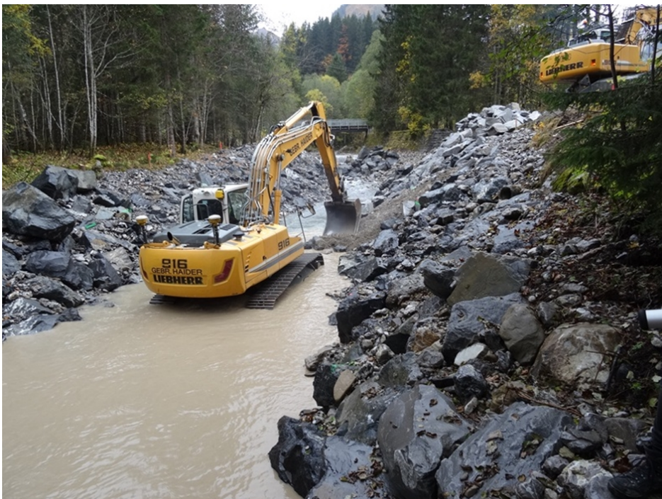
Abb. 2: Durchmischen des angelieferten Schüttmaterials mit dessen Einbau (Alban Lunardon)
