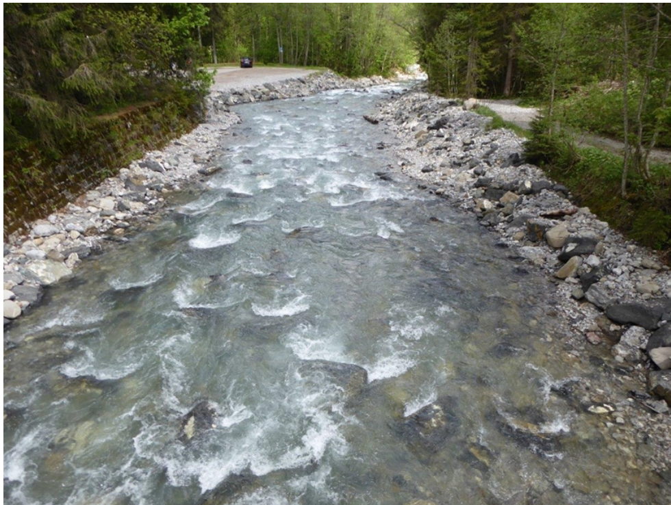
Abb. 5: Abfluss oberen Rampenteil (Josef Sarcher)
