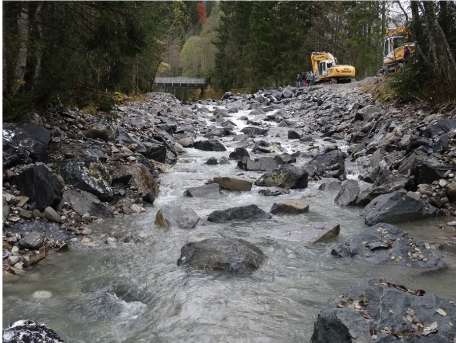
Abb. 3: Fertiggestellte untere Rampenteile (Alban Lunardon)
