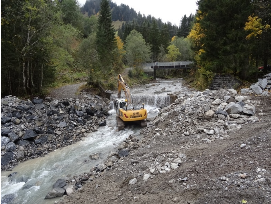
Abb. 1: Einbringen von Schüttmaterial mit altem Querbauwerk (Alban Lunardon)
