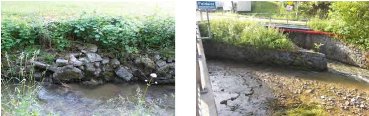
Abbildung 184 Links: Beschädigte Ufermauer und Sohlenerosion an der Feldaist (Quelle: Gewässerbezirk Linz)
