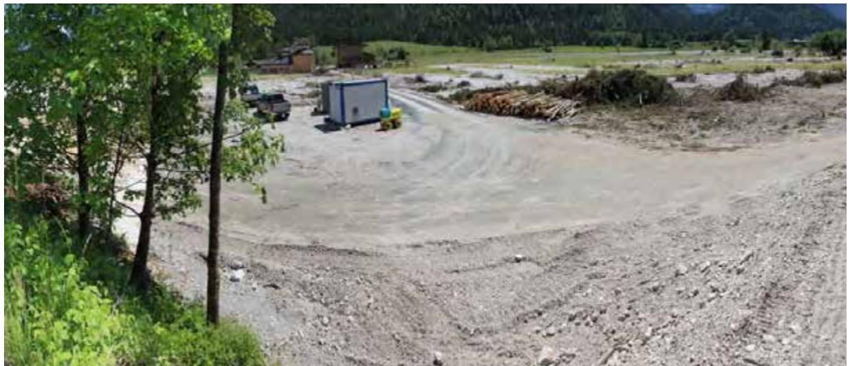
Abbildung 9 Abflussverlegung durch Dammbbruch Haselbach (Quelle: BWV Tirol)
