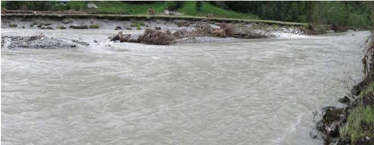
Abbildung 116 Ufererosion und Zerstörung der Ufersicherung auf ca 100 flm bei Fkm 9.00 (Quelle: IWHW)
