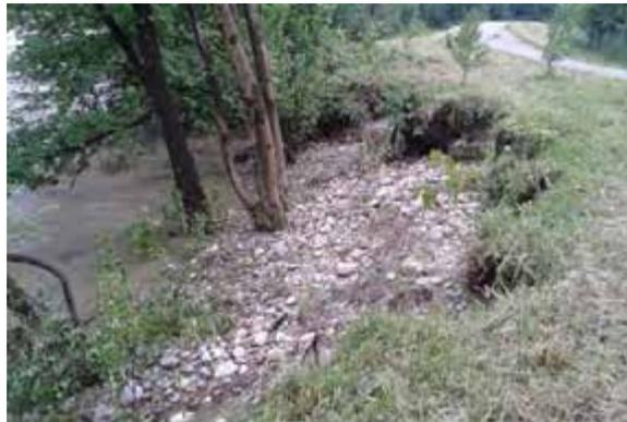
Abbildung 172 Links/Rechts: Beschädigter Hochwasserschutzdamm bei Fkm 9.90 (Quelle: GWB Gmunden)
