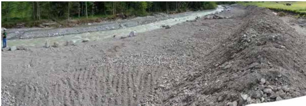
**Abbildung 123** Großflächige Erosion und Ablagerungen sowie Verwerfung des Gerinnes (Quelle: IWHW)
