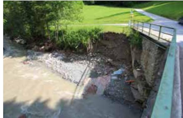
Abbildung 21 Links: Absacken der Terrasse in unmittelbarer Ufernähe (Quelle: IWHW)
