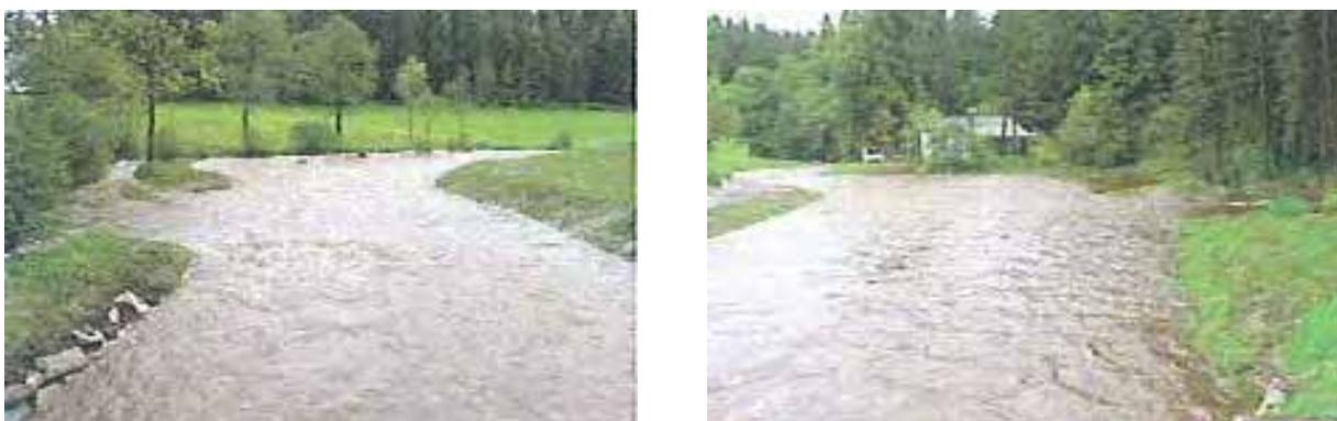
Abbildung 197 Links/Rechts: Unterspülte Steinsicherung des Distlbaches (Quelle: GWB Grieskirchen)
