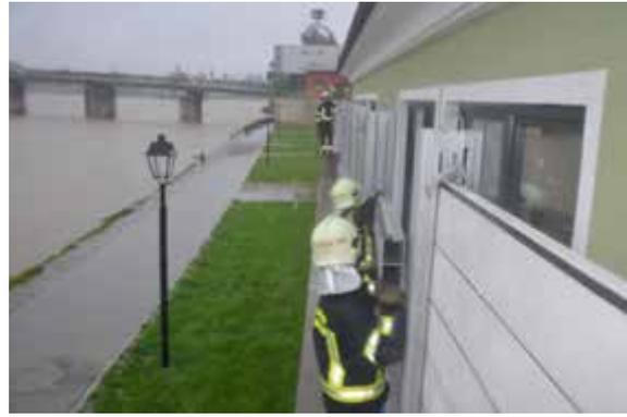
**Abbildung 240** Links: Mobiler Hochwasserschutz in Schärding (Quelle: ooe.orf.at)
