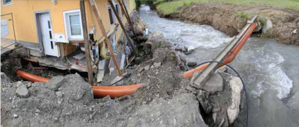
**Abbildung 23** Beschädigung des Fundamentes (Quelle: IWHW)
