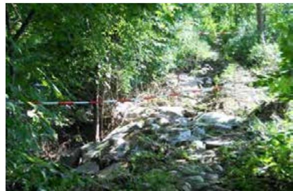
**Abbildung 168** Links/Rechts: Erosierte Böschung samt Bewuchs (Quelle: Gewässerbezirk Linz)
