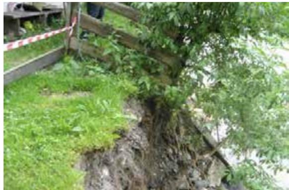
Abbildung 146 Links/Rechts: Zerstörter Steinverbau am linken Enns Ufer (Quelle: Land STMK)
