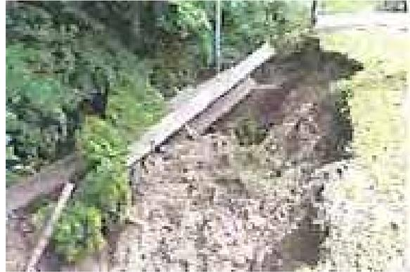
**Abbildung 205** Links: Freigespültes Brückengeländer und dessen Fundament in Aigen (Quelle: GWB Grieskirchen)
