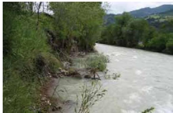
Abbildung 147 Links/Rechts: Linkes Ufer der Enns, HW-Schutzdamm wurde zerstört (Quelle: Land STMK)
