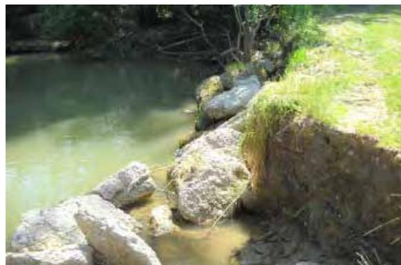
Abbildung 216 Links/Rechts: Zwei der drei Uferschäden am Sulzbach (Quelle: Gewässerbezirk Linz)
