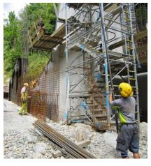
Errichtung einer Filtersperre am Schmiedbognerbach, Stgde. Oberwölz
