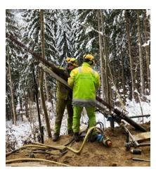
Errichtung eines Bohrankers für die Steinschlagverbauung Oberweg, Stgde. Judenburg
