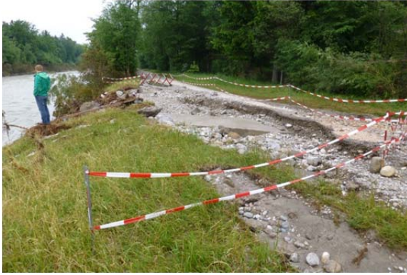
Abbildung 7-37: Links: Uferanrisse in der Gemeinde Wals entlang der Saalach (Quelle: IWHW); Rechts: Geschiebeablagerungen bei der Grundschwelle in der Gemeinde Wals (Quelle: IWHW)
