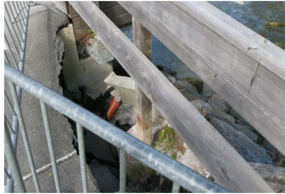
Abbildung 7-19: Links: Feinsedimentablagerung bei Fkm 24.80 (Quelle: Amt der Tiroler Landesregierung); Rechts: Uferanrisse am rechten Widerlager des Badstegs (Quelle: Amt der Tiroler Landesregierung)
