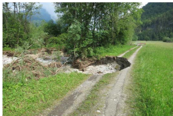
Abbildung 7-20: Links: Anriss im Trenndamm (Quelle: BWV Tirol); Rechts: Anrisse entlang des alten Griessbach-Bettes (Quelle: Amt der Tiroler Landesregierung)
