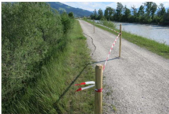
Abbildung 7-20: Links: Anriss im Trenndamm (Quelle: BWV Tirol); Rechts: Anrisse entlang des alten Griessbach-Bettes (Quelle: Amt der Tiroler Landesregierung)
