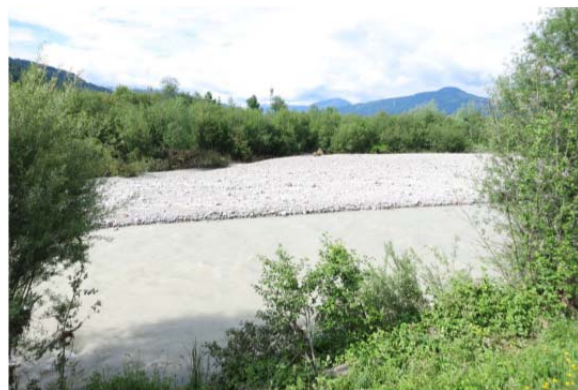
Abbildung 7-32: Links: Geschiebeablagerungen im Bereich der Aufweitung (Quelle: Amt der Tiroler Landesregierung); Rechts: Fkm 0.29 Ablagerungen im Aufweitungsbereich (Quelle: Amt der Tiroler Landesregierung)
