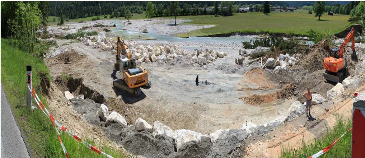
Abbildung 7-16: Geschiebeablagerungen entlang des Haselbaches (Quelle: IWHW)
