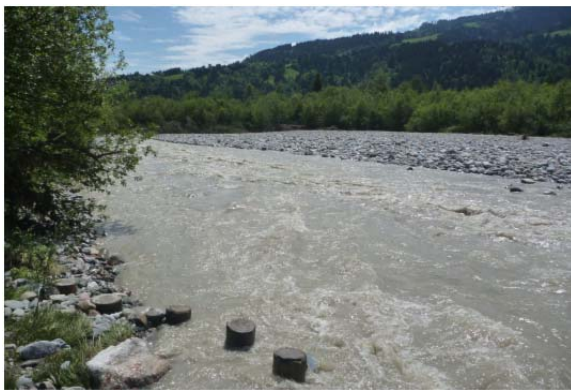
Abbildung 7-32: Links: Geschiebeablagerungen im Bereich der Aufweitung (Quelle: Amt der Tiroler Landesregierung); Rechts: Fkm 0.29 Ablagerungen im Aufweitungsbereich (Quelle: Amt der Tiroler Landesregierung)
