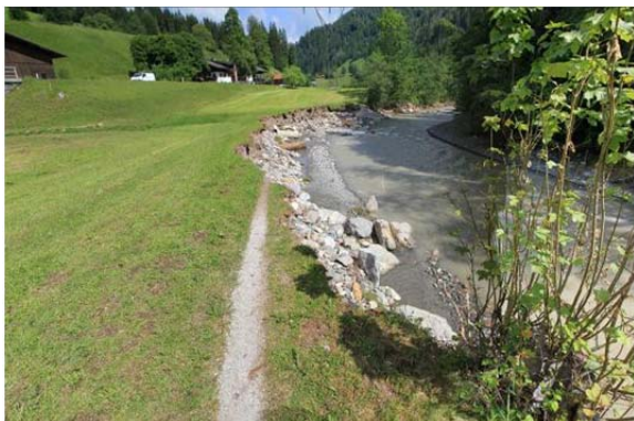
Abbildung 7-27: Links: Uferanriss in Nähe des Gasthauses Oberstegen – Erosion des Wanderweges (Quelle: IWHW); Rechts: Uferanriss und Ufererosion in Ellmau (Quelle: IWHW)
