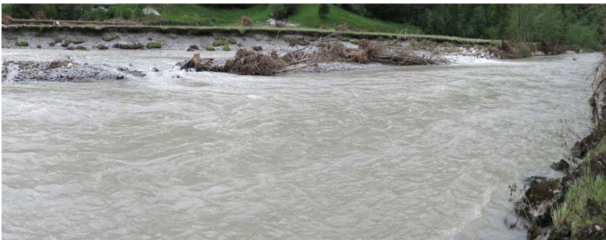
Abbildung 7-21: Ufererosion und Zerstörung der Ufersicherung auf ca 100 flm bei Fkm 9.00 (Quelle: IWHW)
