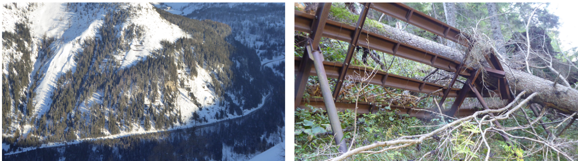
Abb. 1 u.2: Lawinengefährdung durch Schneedruckereignis und Schäden an den Lawinerverbauung
