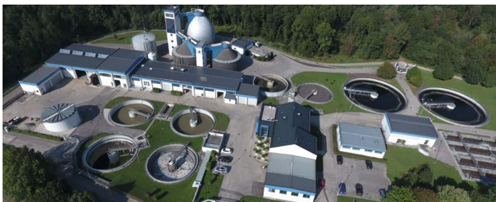
Luftbild Kläranlage Amstetten mit Faultürmen im Hintergrund
