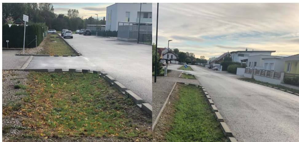
links: Einseitige Sickermulde in der Bachgasse, Ortschaft Engelhartstetten
