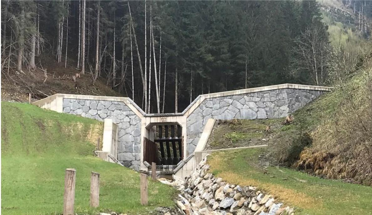
Abbildung 1: Filterbauwerk am Gschwendgraben (linker Zubringer zum Thumersbach, 1. DP)
