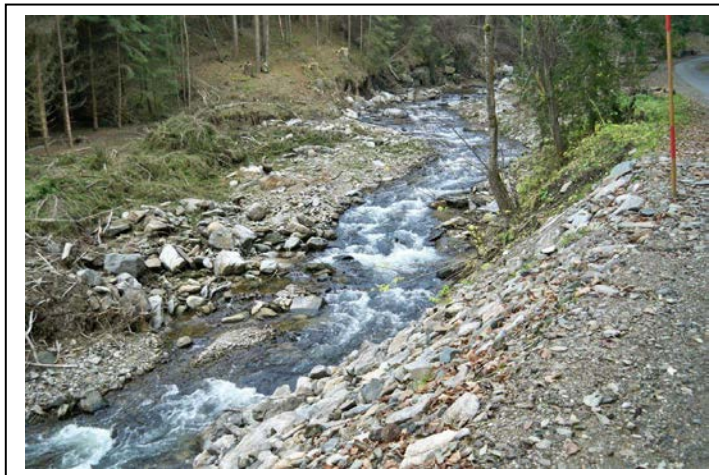
Abb. A3: Auerlingbach; lokale Ufersicherung (Foto: Wolfgang Honsig-Erlenburg, Amt der Kärntner Landesregierung)
