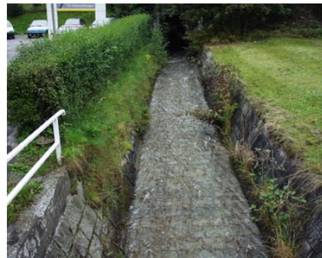
Abbildung 29: Aufgrund geringer Wassertiefe nicht passierbare Sohlverbauungen (Foto: Amt der Salzburger Landesregierung, Ref. Gewässerschutz)
