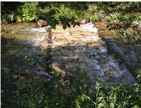
Abbildung 29: Aufgrund geringer Wassertiefe nicht passierbare Sohlverbauungen (Foto: Amt der Salzburger Landesregierung, Ref. Gewässerschutz)
