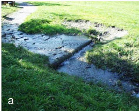
Abbildung 7: Beispiele für lokale Sohlstabilisierungsmaßnahmen in ansonsten unverbauten Gewässerabschnitten (Klasse 1): a.: Sohlschwelle (Querholz); b.: Sohlstabilisierung mit Absturz unter Brücke (Fotos: Amt der Salzburger Landesregierung, Ref. Gewässerschutz)
