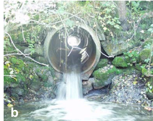
Abbildung 31: a.: aufgrund zu dünner Wasserlamelle nicht passierbare Verrohrung; b.: Verrohrung mit nicht passierbarem Absturz am unteren Ende (Fotos: Amt der Salzburger Landesregierung, Ref. Gewässerschutz)
