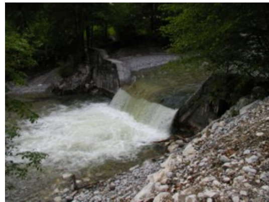
Abbildung 27: Beispiele für nicht passierbare Querbauwerke mit abgelöstem Strahl (vollkommener Überfall) (Fotos: Amt der Salzburger Landesregierung, Ref. Gewässerschutz)
