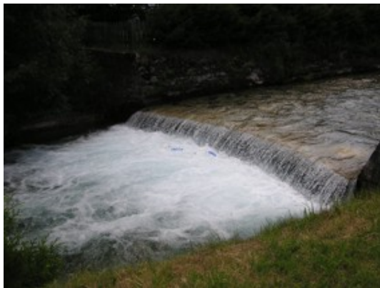
Abbildung 27: Beispiele für nicht passierbare Querbauwerke mit abgelöstem Strahl (vollkommener Überfall) (Fotos: Amt der Salzburger Landesregierung, Ref. Gewässerschutz)
