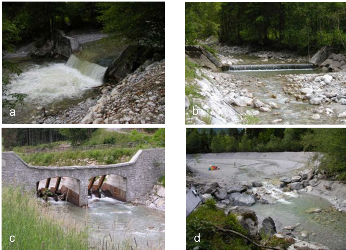
Abbildung 23: Verschiedene Typen von schutzwasserbaulichen Querbauwerken (a.: Absturzbauwerk, b.: Sohlgurt, c.: Geschiebesperre, d.: raue Rampe) (Fotos: Amt der Salzburger Landesregierung, Ref. Gewässerschutz)
