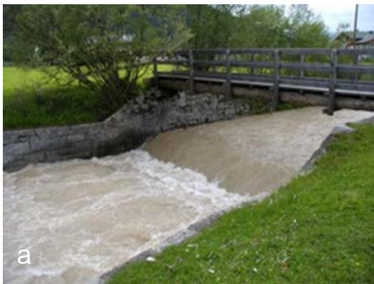
Abbildung 28: a.: für Rhithralfische gerade noch durchschwimmbares Absturzbauwerk mit anliegendem Wasserpöhlern; b.: aufgrund dünner Wasserlamelle nicht durchschwimmbarer Wasserpöhlern (Fotos: Amt der Salzburger Landesregierung, Ref. Gewässerschutz)
