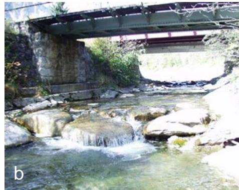
Abbildung 7: Beispiele für lokale Sohlstabilisierungsmaßnahmen in ansonsten unverbauten Gewässerabschnitten (Klasse 1): a.: Sohlschwelle (Querholz); b.: Sohlstabilisierung mit Absturz unter Brücke (Fotos: Amt der Salzburger Landesregierung, Ref. Gewässerschutz)
