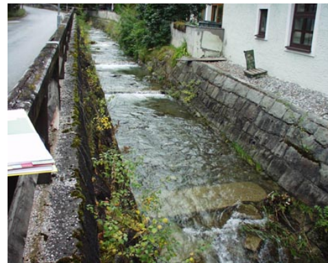
Abbildung 9: Abschnitte mit durchgehenden Schwellenketten und Substrat zwischen den Bauwerken (Klasse 3) (Fotos: Amt der Salzburger Landesregierung, Ref. Gewässerschutz)
