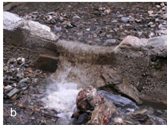
Abbildung 28: a.: für Rhithralfische gerade noch durchschwimmbares Absturzbauwerk mit anliegendem Wasserpöhlern; b.: aufgrund dünner Wasserlamelle nicht durchschwimmbarer Wasserpöhlern (Fotos: Amt der Salzburger Landesregierung, Ref. Gewässerschutz)
