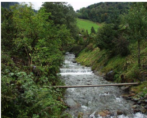
Abbildung 8: Abschnitte mit lokalen Sohlstabilisierungsmaßnahmen und offenem Substrat zwischen den Bauwerken (Klasse 2) (Foto: Amt der Salzburger Landesregierung, Ref. Gewässerschutz)
