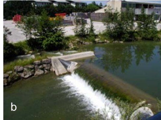
Abbildung 24: Beispiele für Querbauwerke mit sonstigem Zweck. (a.: nicht passierbare Verrohrung; b.: Messwehr) (Fotos: Amt der Salzburger Landesregierung, Ref. Gewässerschutz)
