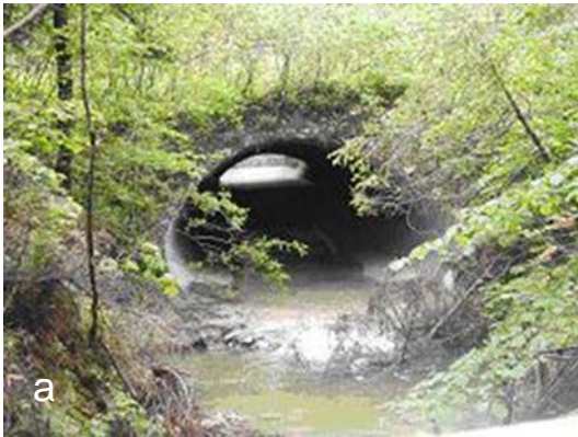
Abbildung 24: Beispiele für Querbauwerke mit sonstigem Zweck. (a.: nicht passierbare Verrohrung; b.: Messwehr) (Fotos: Amt der Salzburger Landesregierung, Ref. Gewässerschutz)
