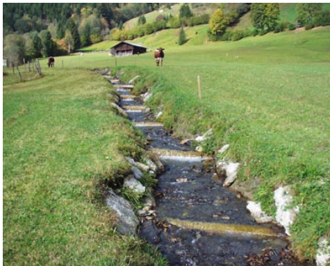
Abbildung 9: Abschnitte mit durchgehenden Schwellenketten und Substrat zwischen den Bauwerken (Klasse 3) (Fotos: Amt der Salzburger Landesregierung, Ref. Gewässerschutz)
