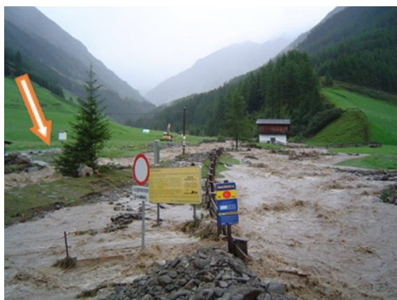
Abbildung 1: Hairlachbach oberhalb der Gemeindestraßenbrücke in Niederthai beim Hochwasser 2005 (das Bachbett befindet sich links im Bild - siehe Pfeil)
