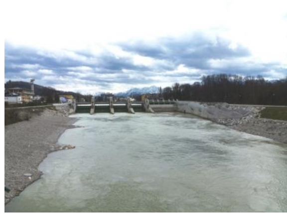
Abb. 2: Wehranlage KW Sohlstufe Lehen
