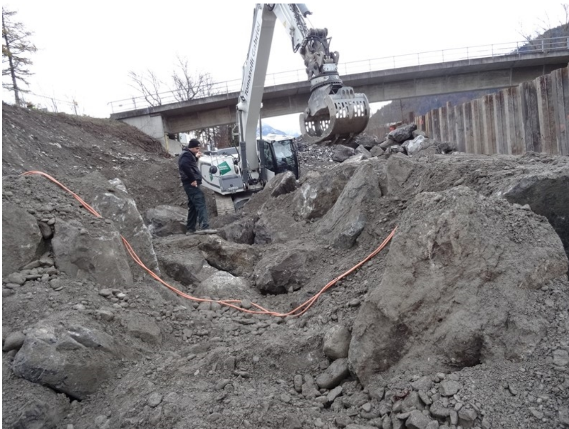
Abb. 2: Verlegung der Riegel- und Beckensteine (Alban Lunardon)
