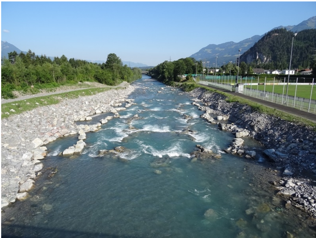
Abb. 4: Fertigstellung obere Rampe (Alban Lunardon)
