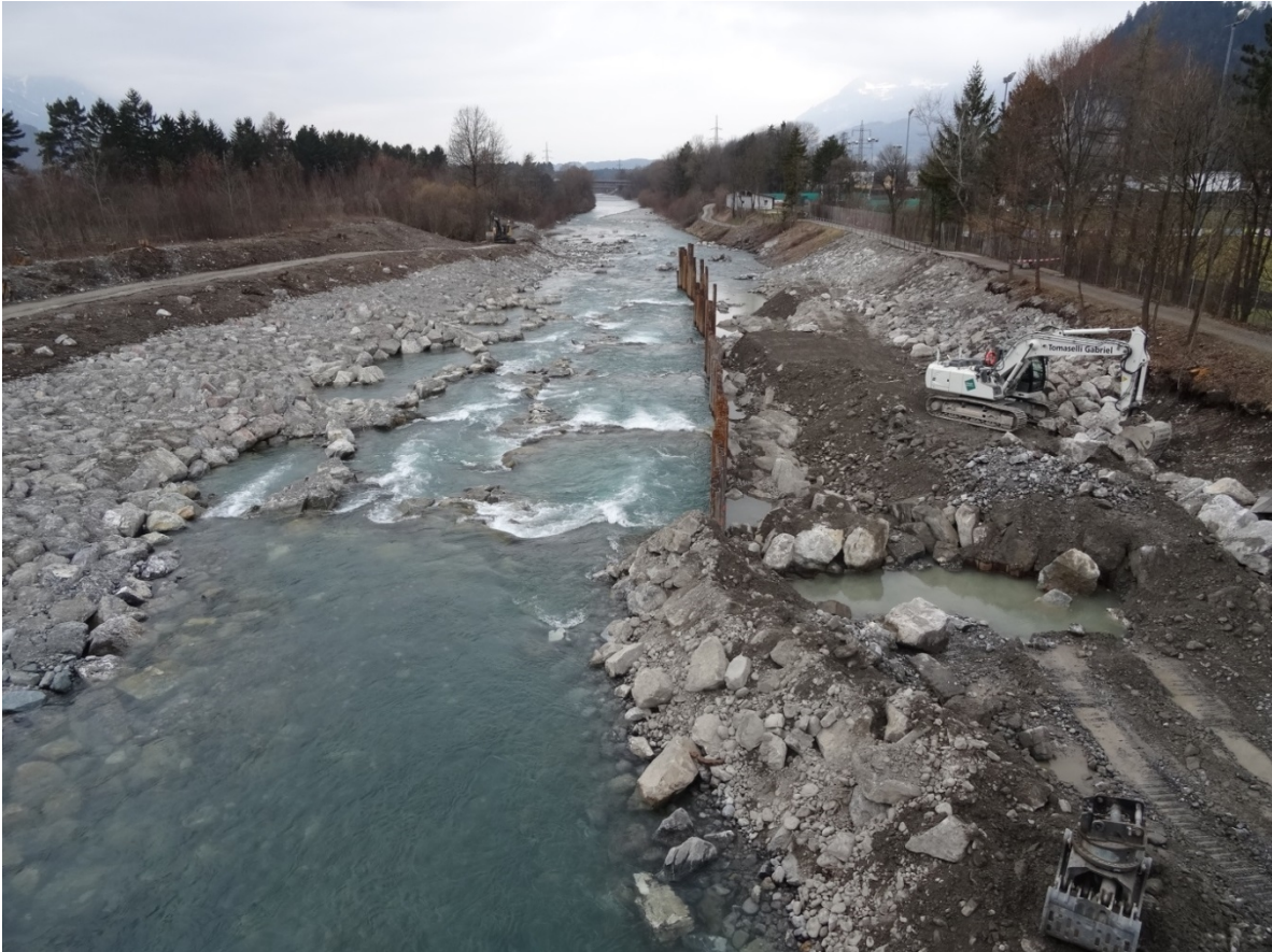
Abb. 3: Spundwand zur trockenen Verlegung der Rampe (Alban Lunardon)
