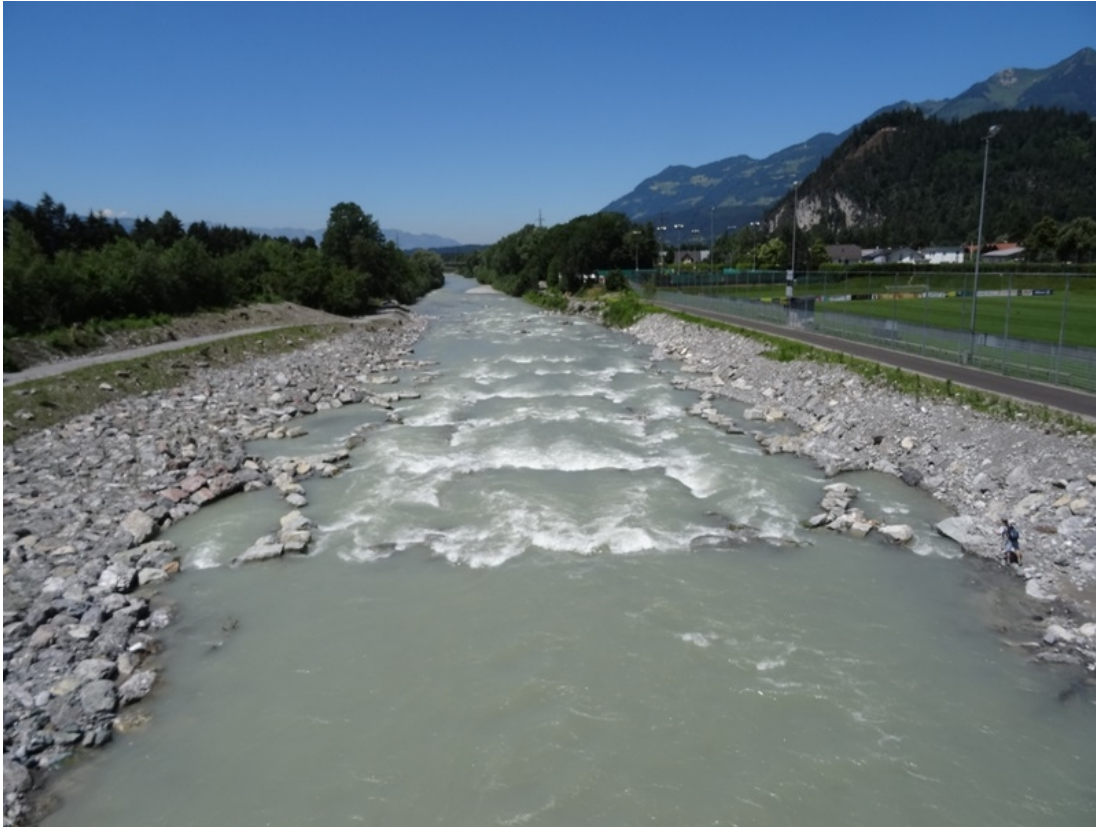
Abb. 5: Fertigstellung obere Rampe höherer Abfluss (Alban Lunardon)
