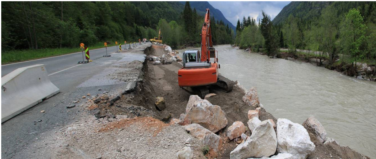
Abbildung 11: Komplette Zerstörung des linken Ufers an der Großache. (© oben: BWV Tirol, unten: IWHW)
