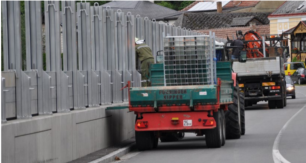
Abbildung 27: Aufbau mobiler Elemente durch die Feuerwehr Spitz an der Donau 2013.
