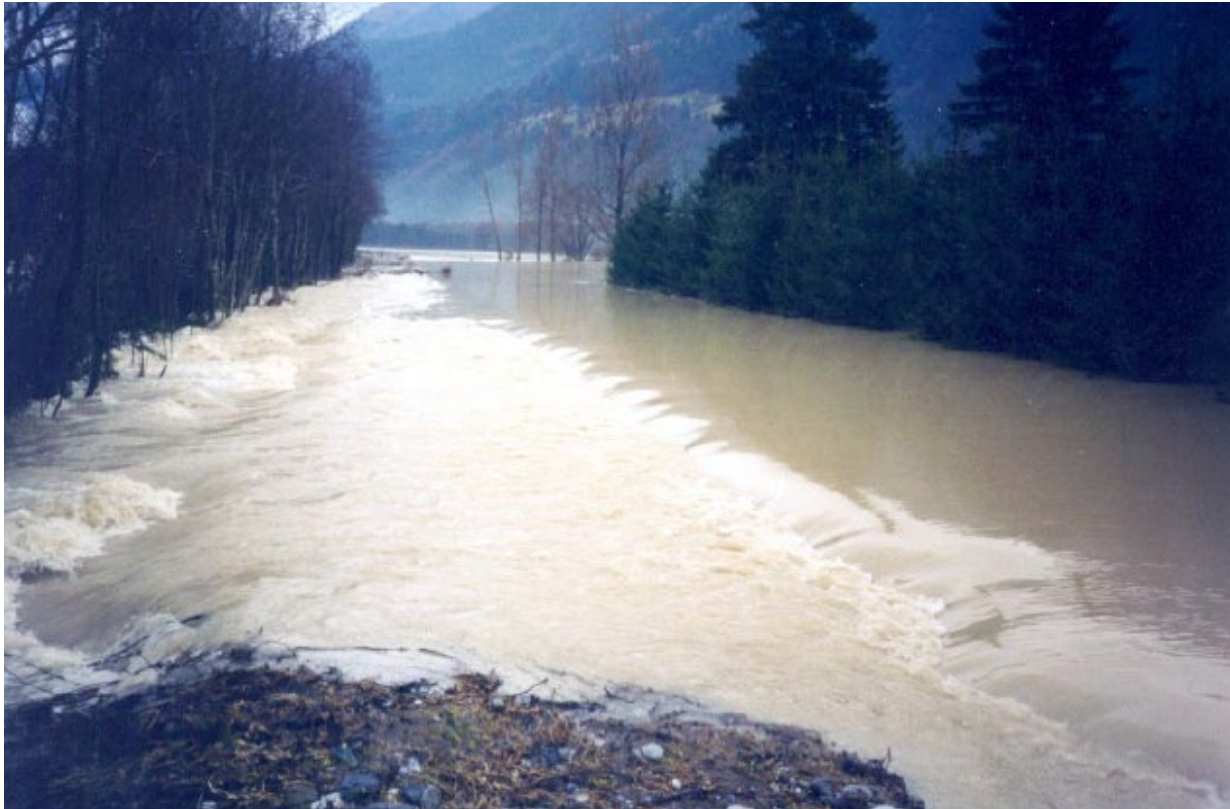
Abbildung 23: Überströmstrecke an der Gail. (© Land Kärnten)
