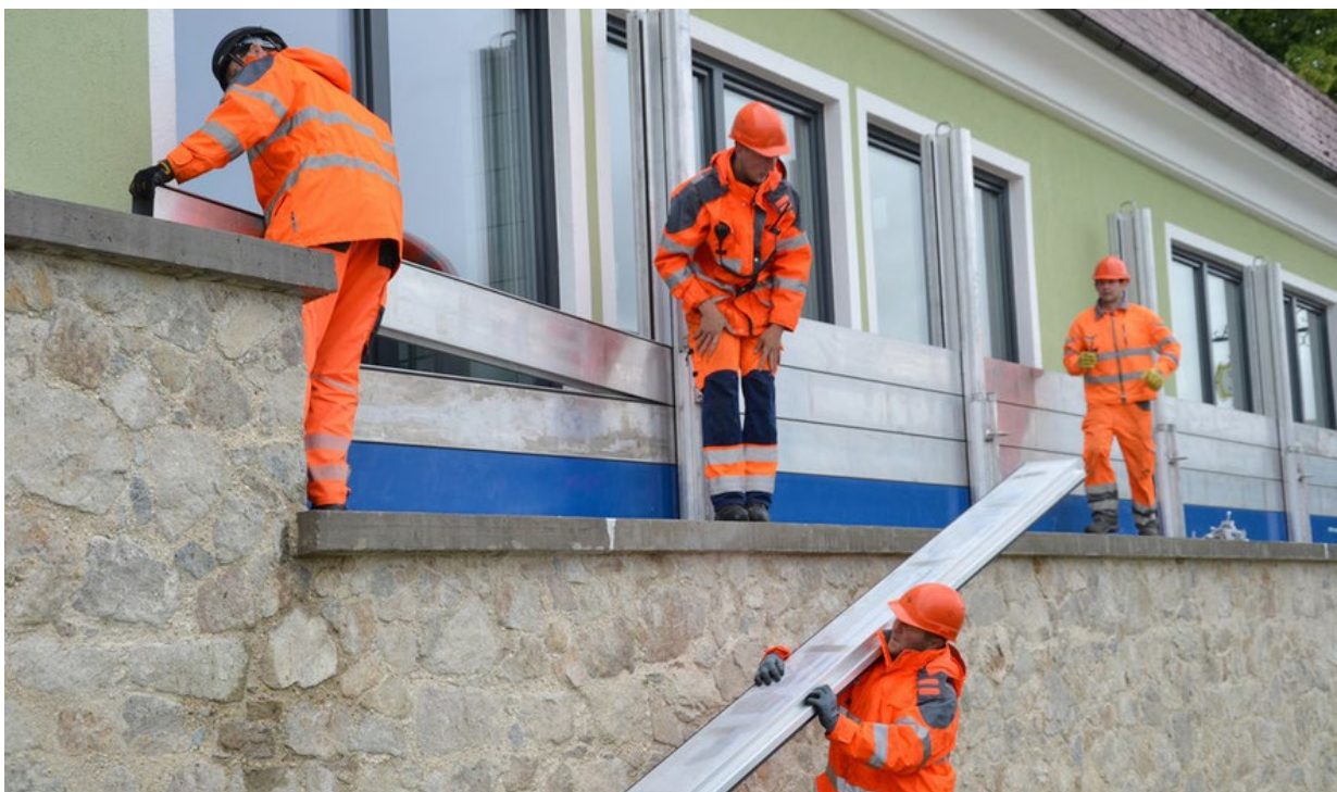
Abbildung 21: Aufbau eines mobilen Hochwasserschutzes in Schärding. (© ooe.orf.at)
