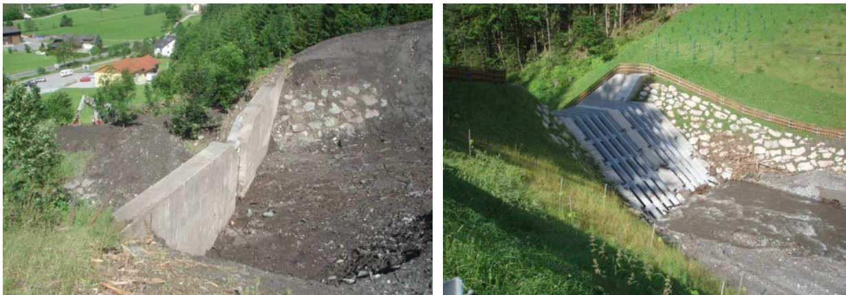
Abbildung 24: Links: Sperre Greimelbach, Gemeinde Waldrechts; rechts: Sperre mit Holzrechen Teichenbach, Gemeinde Kalwang. (©BMLFUW, 2012)
