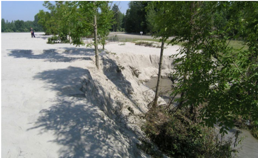
Abbildung 8: Feinsedimentablagerungen im Eferdinger Becken. (© Verbund)
