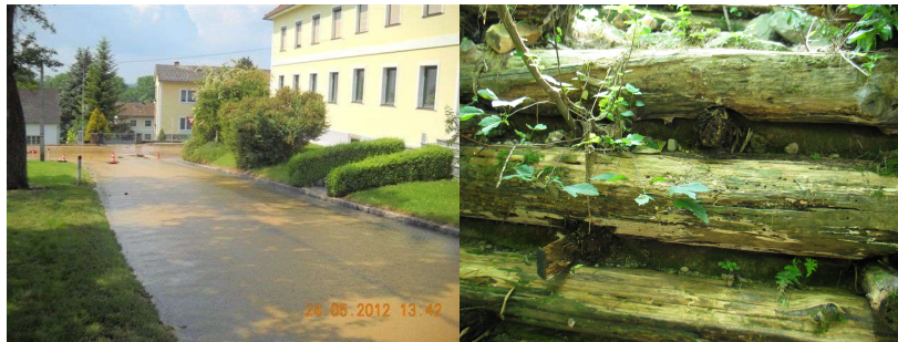
Abb. 1 & 2: Ereignis 2012 (Begleitende Straße beaufschlagt) & aktuelle Zustand der Sperrenstaffelung (© IKW & die.wildbach)
